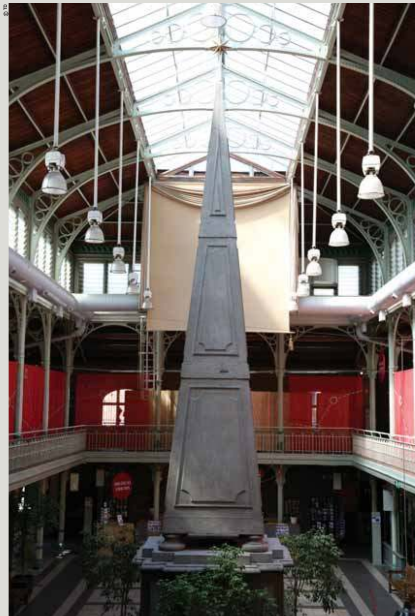
Charpente métallique et ancienne fontaine
