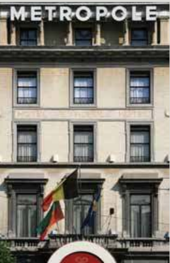
Ancienne Caisse d'épargne (n° 31)
