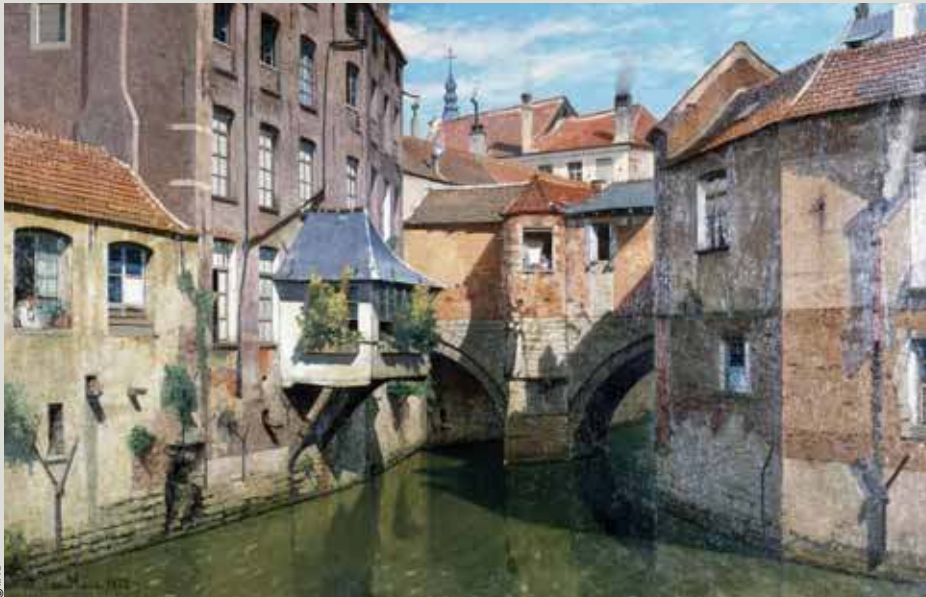
Pont et écluse de la première enceinte (J.-B. Van Moer)
